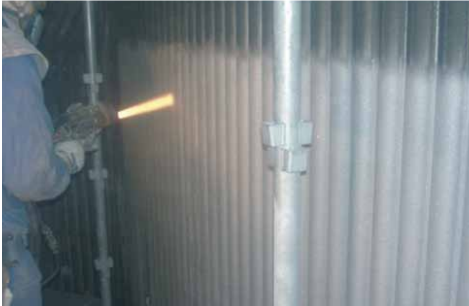
現地での高速フレイム溶射
