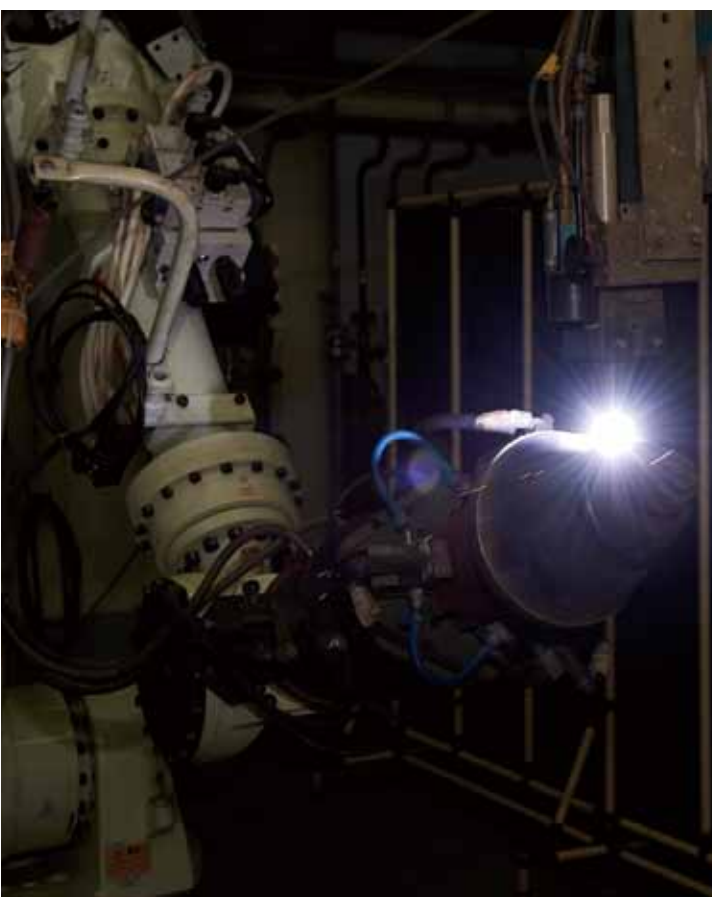
多関節ロボットによる曲面部へのPTA施工
