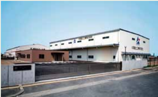
和歌山工厂（和歌山县 和歌山市）
